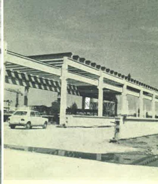
L'inclinazione verso l'alto delle due ali superiori forma un canale longitudinale continuo particolarmente adatto per la raccolta delle acque piovane. La curvatura della trave, dovuta all'effetto della precompressione, garantisce il naturale smaltimento delle stesse verso l'estremità. Essendo la larghezza superiore della trave pari a 1,25 m e l'interasse di esercizio di 2,50 m, la chiusura dell'interspazio tra ala e ala è
