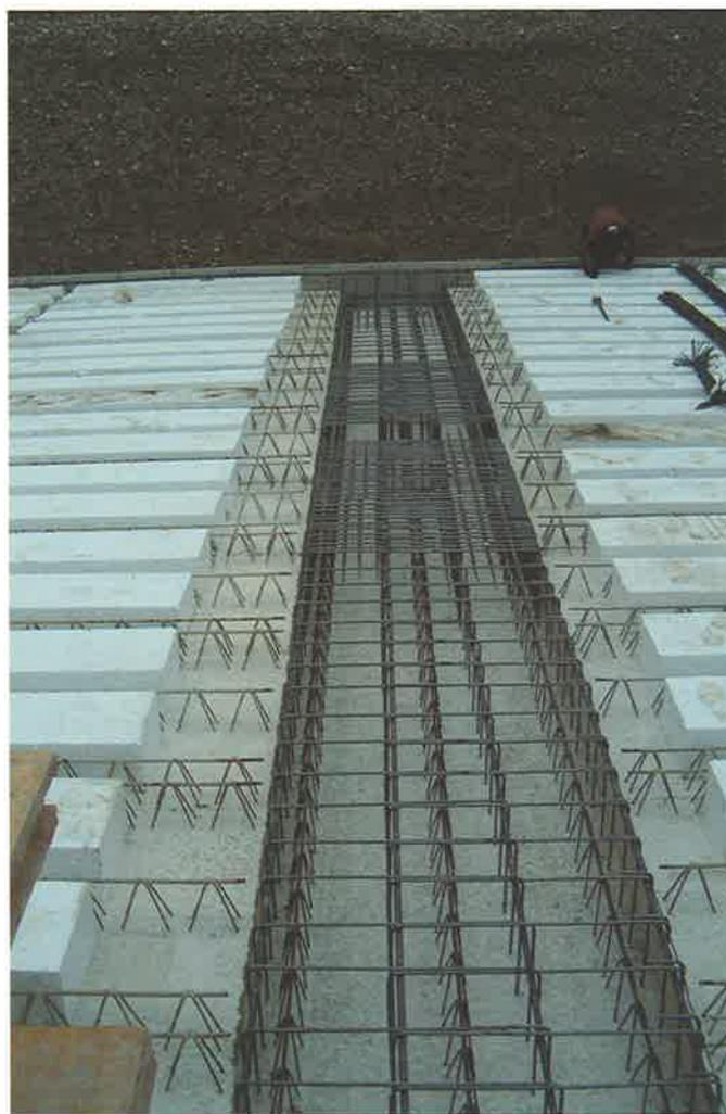
Questo manufatto ben si presta anche alla sostituzione dei vecchi solai in legno, per i vantaggi dati dalla leggerezza e per la facilità dei collegamenti alle strutture portanti.
